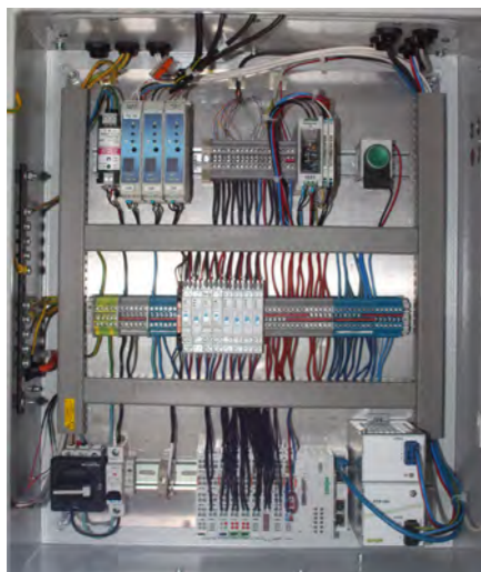
Data acquisition unit for monitoring air quality in a pig house. Datenerfassungseinheit zur Messung der Luftqualität im Schweinestall.
