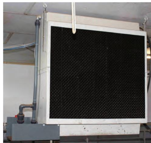
Abbildung 1. Wasserwand mit integrierter Ionisation.
