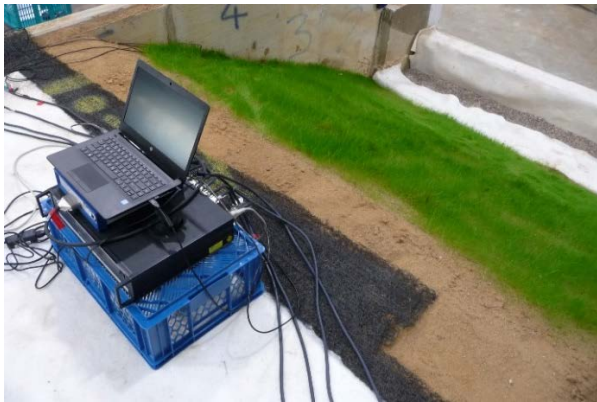
Abbildung 2. Ansicht der Deichkrone in Richtung der mit Gras bewachsenen Luftseite des Versuchsdeichs der TU Dresden mit Messequipment zur mehrkanaligen Impedanzmessung.
